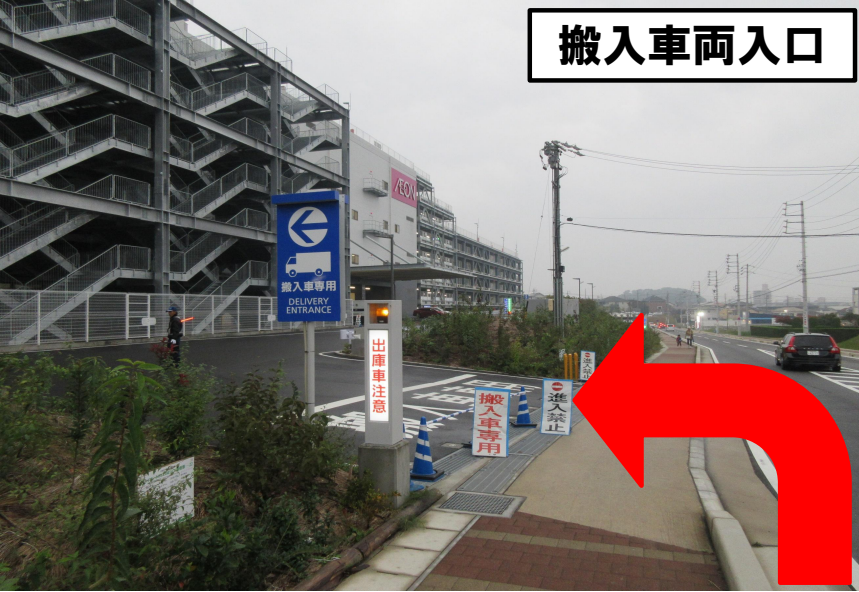
搬入口ガードレール
